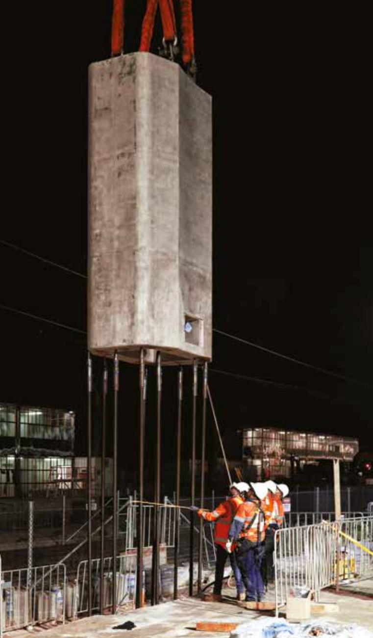
Installazione del pontile - Murrumbreena
